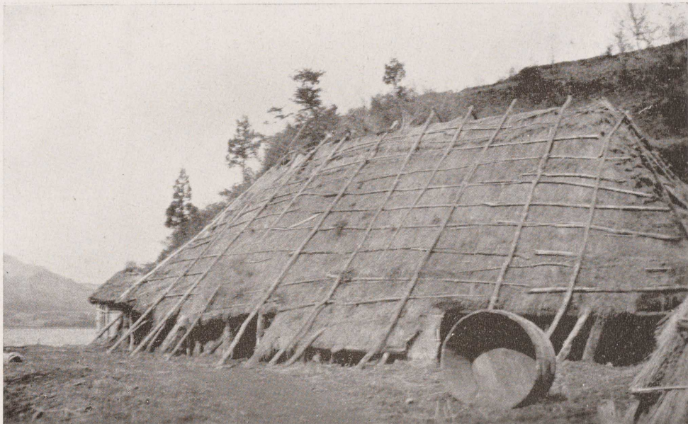
場藏貯鹽及場鹽製水海ルケ於ニ村崎赤内管局支春三
